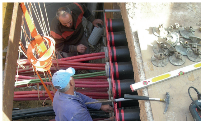
Installazione dei passaggi impermeabili HSI 150-K2 e dei tubi di rivestimento divisi FZR-G.
