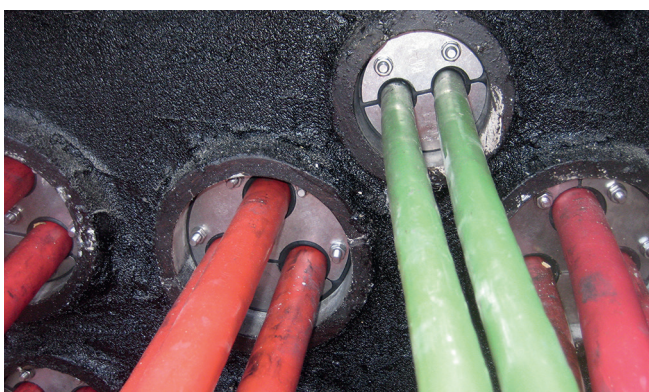
Tutti i cavi sono stati successivamente sigillati nei tubi di rivestimento con guarnizioni anulari HRD divise, realizzate su misura.
