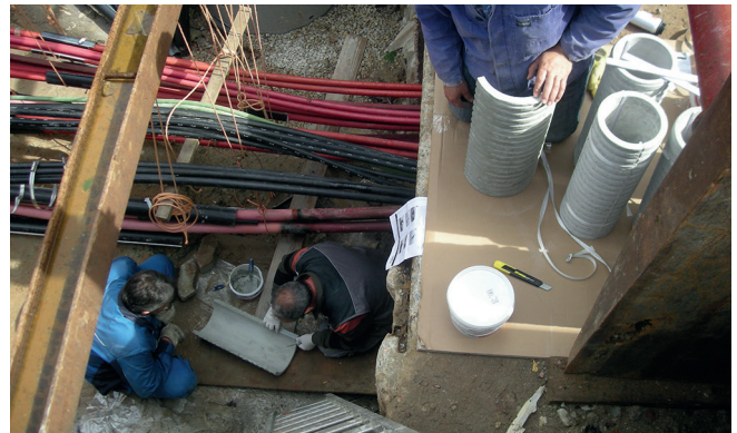
Montaggio dei tubo di rivestimento in fibrocemento divisi FZR-G.
