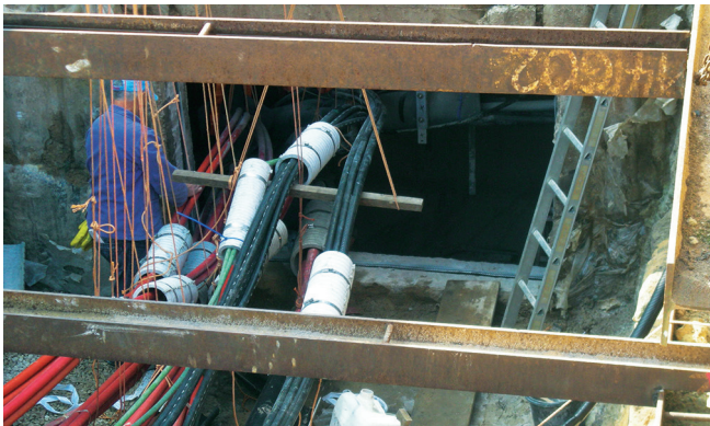
Intorno ai cavi posati e ai tubi di protezione è stata realizzata una cavità e intorno a ogni sistema di cavi sono stati montati dei tubi di rivestimento divisi.
